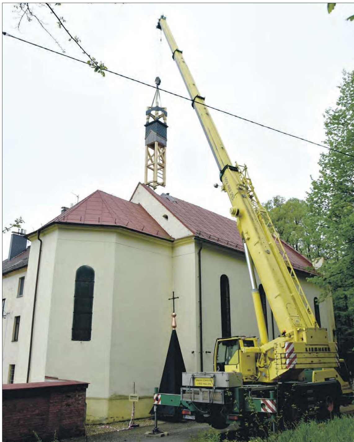
Dźwig osadza główną konstrukcję wieżyczki
