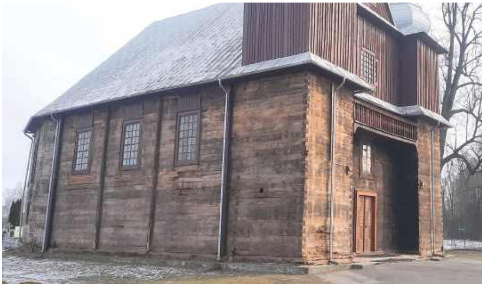
Ruszyły prace na zewnątrz świątyni
