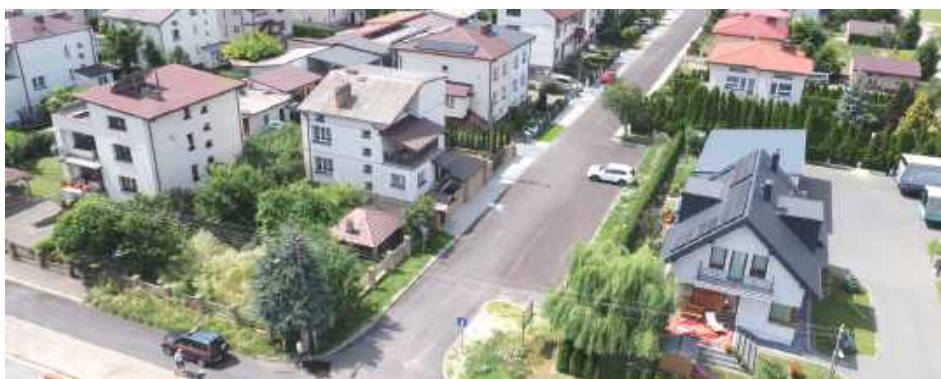
Remont ulicy Andersa został już zakończony
