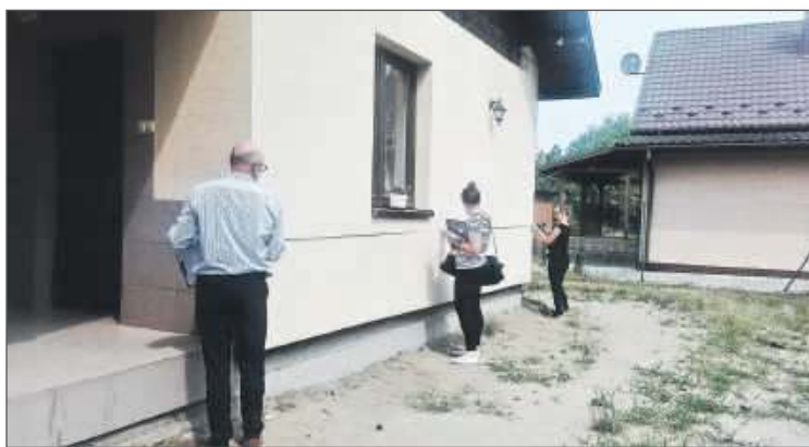
Dom w Żdźarach był mierzony przez nadzór budowlany. Powiatowy inspektor Wojciech Gień tłumaczy, że nie może odnosić się do wyników, a dokumentacja została przekazana dalej. Fot. M. Kościuszko.
