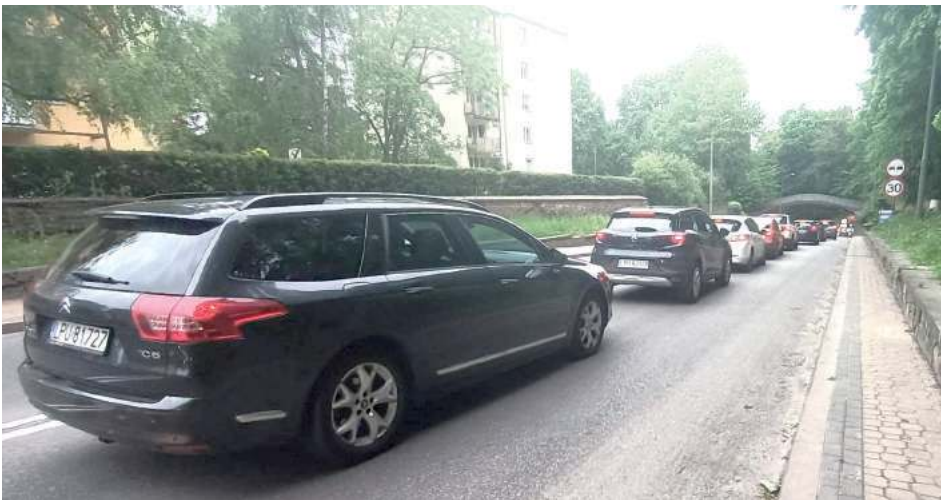
W związku z remontem kładki na ul. Głębokiej wprowadzono ruch wahadłowy. Remont ma zakończyć się w połowie lipca
