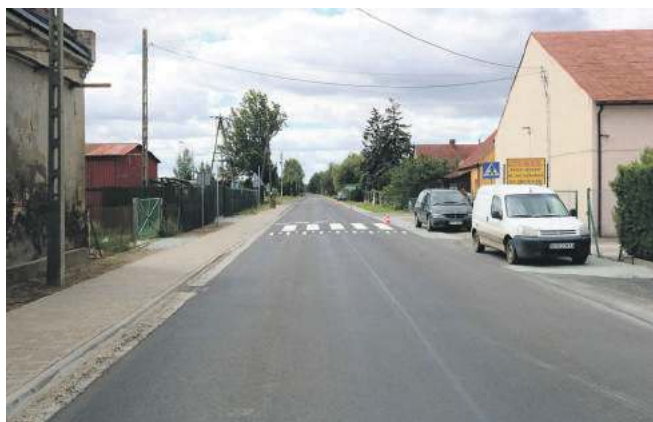
Nowa nawierzchnia drogi w miejscowości Ujeździec Wielki
