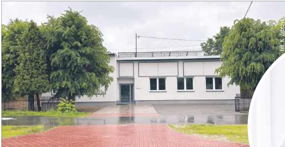
Nowa przychodnia znajduje się w miejscu starej biblioteki (Kupno 267).
