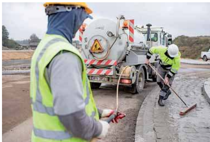
Budowa nowego węzła w Pieńkach
