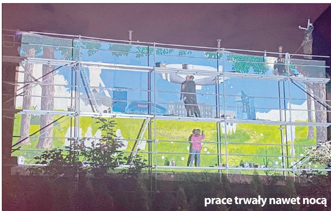
najpierw ocieplono i otynkowano ściany
