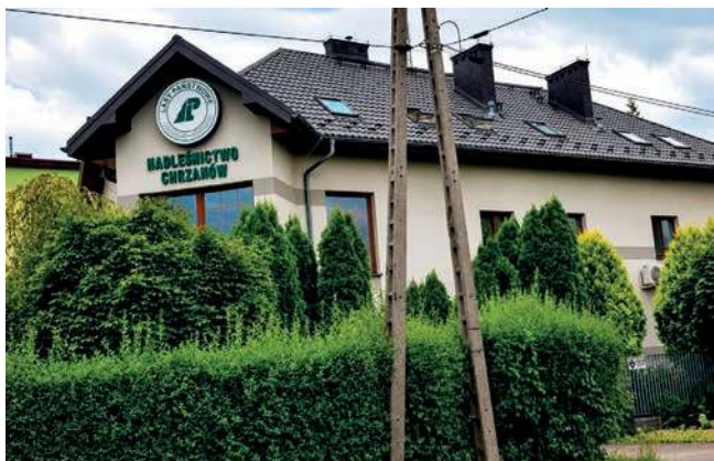
Obecna siedziba leśników znajduje się przy ruchliwej drodze
