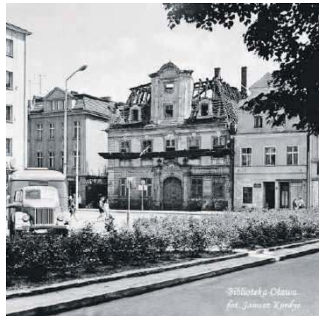
Tak wyglądała kamienica po pożarze w roku 1969 r.
