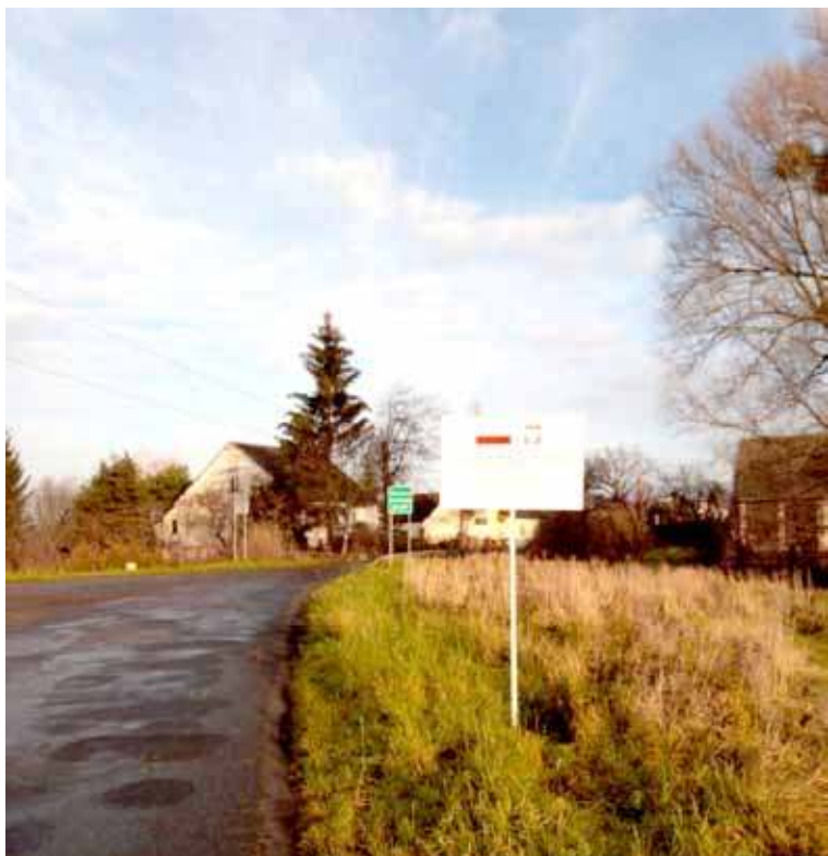
Firma Strabag wykona gruntowną przebudowę drogi w Kunowie, która jest w bardzo złym stanie
