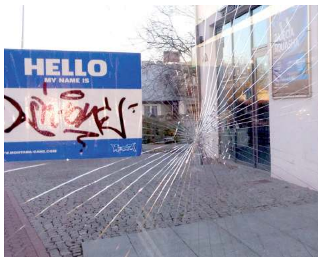
Przystanek przy ul. Narutowicza. Roztrzaskana szyba, wlepka z graffiti i uszkodzony kosz na śmieci. Kilka metrów dalej zamontowana jest kamera przy lokalu gastronomicznym
