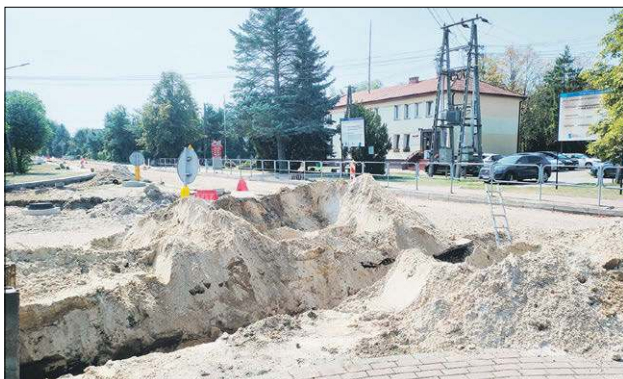
Trwają prace przy budowie kanalizacji w Drelowie
