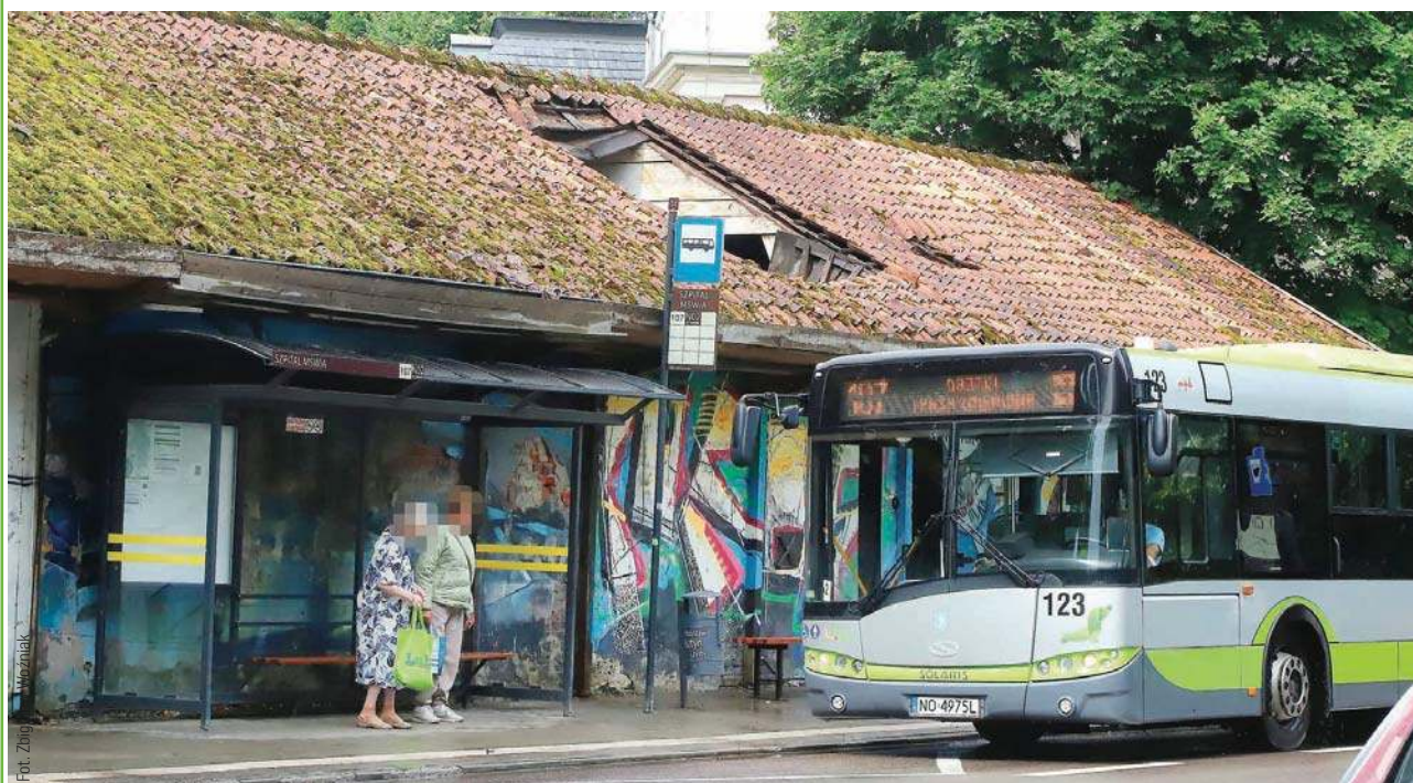
Pasażerowie nie mogą czuć się bezpiecznie przy al. Sybiraków
