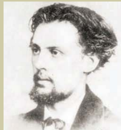
Adam Chmielowski studiował w Puławach, w powstaniu stracił nogę. Potem był wybitnym malarzem, a po przejściu duchowej przemiany został zakonnikiem, który jako Brat Albert został opiekunem biedaków i katolickim świętym
