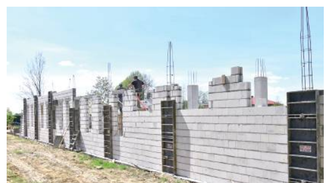
Nowa hala w Potoku Górnym będzie miała ponad 2,1 tys. m2 powierzchni
