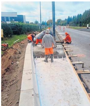
Obecnie trwają prace przy zatokach autobusowych
