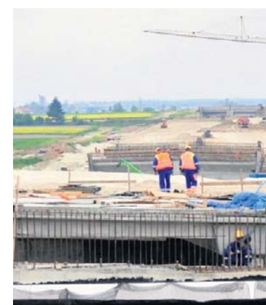
Budowa trasy S17 została podzielona na odcinki
