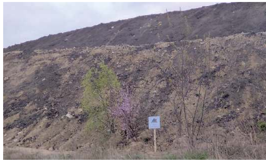
Hałdę ustabilizowano tonami ziemi, posiano trawę, a niebawem posadzone będą krzewy i drzewa
