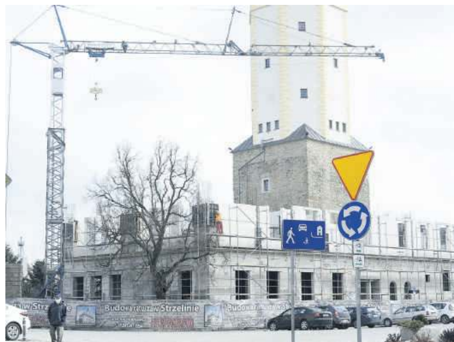
Pierwsza kondygnacja ratusza jest już prawie gotowa
