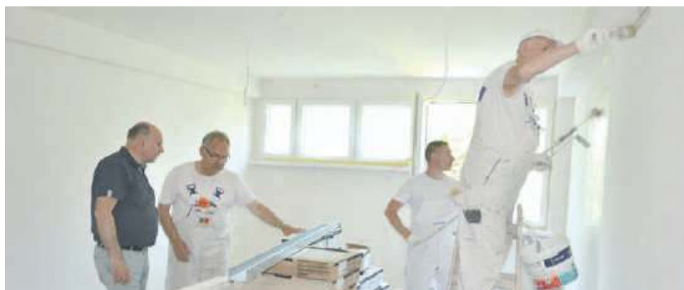
Dobiega końca modernizacja pomieszczeń w budynku byłego internatu, do którego wprowadzi się Powiatowe Centrum Pomocy Rodzinie w Oławie
