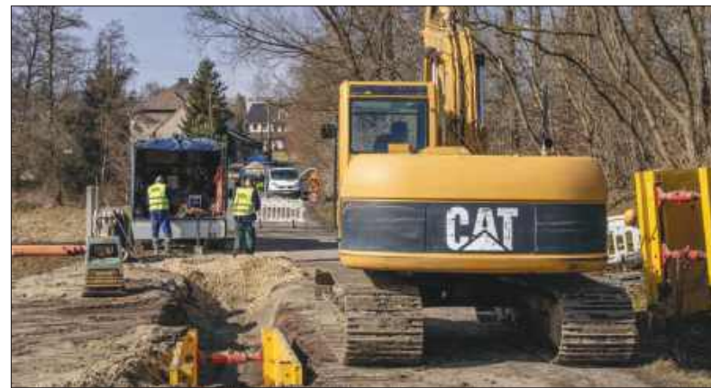
■ Prace na ul. Chełmońskiego w Wodzisławiu FOTO: DOROTA PIECCHA/UM WODZISŁAW ŚL.
