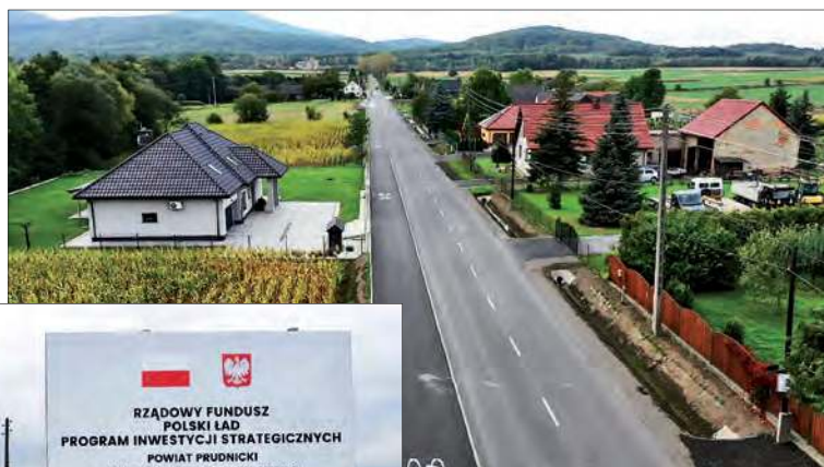
Droga w Moszczance wzbogaciła się o nową ścieżkę pieszo-rowerową
