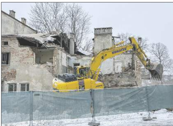
■ Po rozbiórce w miejscu dawnej gorzelni ma stanąć warsztat autobusowy
