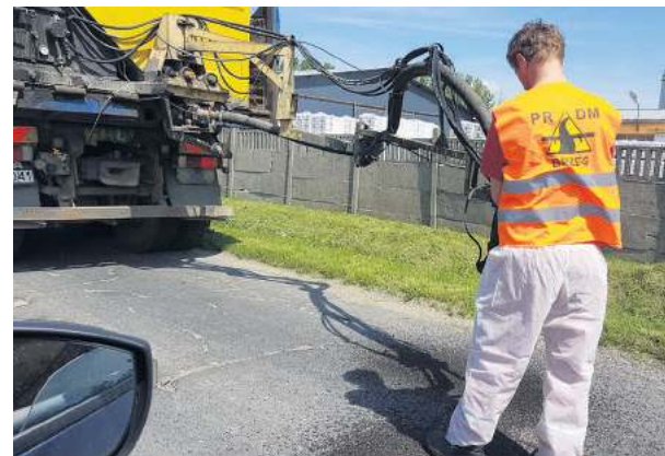
Na prace tzw. patcherem PZD przeznaczono ok. 310 tys. zł
