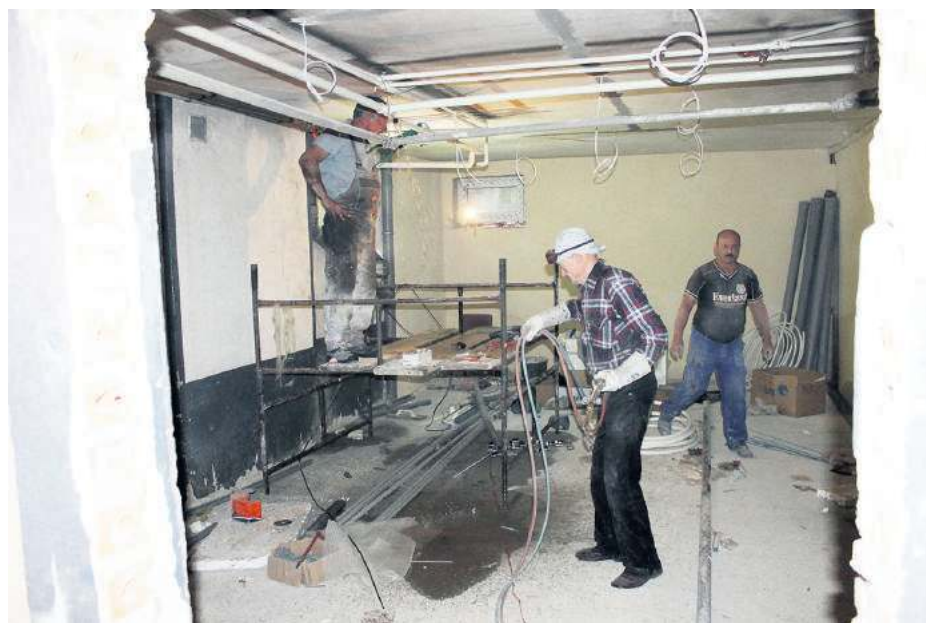
W pomieszczeniach wykonano już instalację wodociągową, kanalizacyjną i elektryczną oraz położono nowe posadzki
