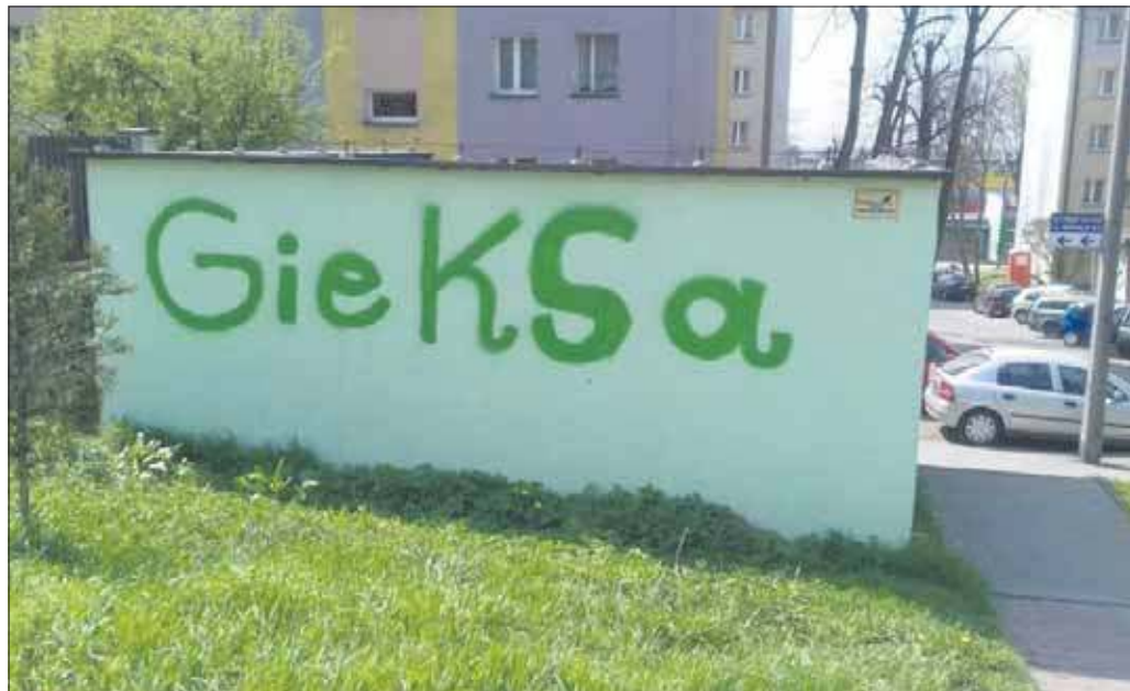
Świeżo pomalowany budynek został zdewastowany
