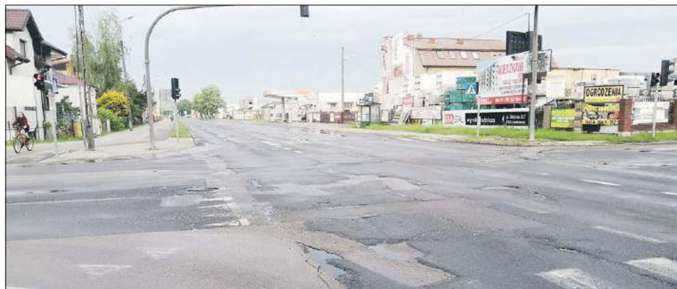
Za ile miasto zmodernizuje odcinek ul. Sidorskiej między al. Jana Pawła II i Kąpielową? Na pewno będzie to kwota wyższa, niż pierwotnie zakładali urzędnicy
