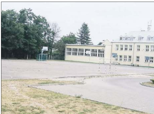
Przetarg na budowę boiska przy SP3 ogłaszany był jesienią ubiegłego roku i został unieważniony. W lutym 2023 radni zagłosowali za dołożeniem do planowanej inwestycji 1,2 mln zł
