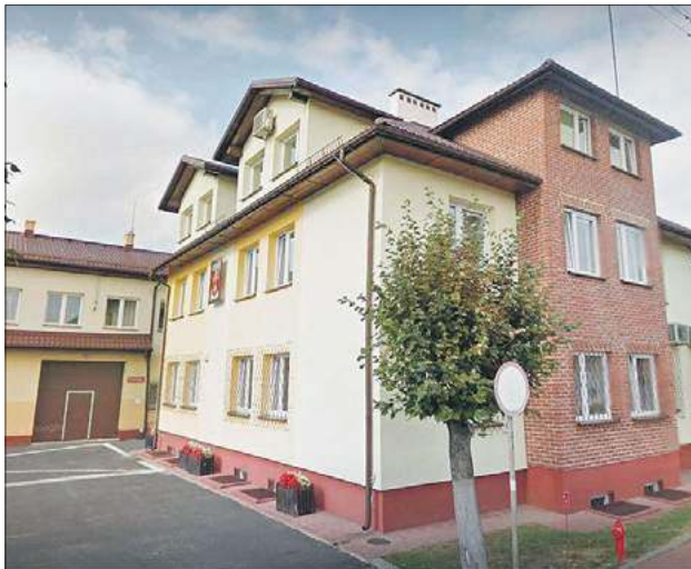
Celem pozyskanego grantu jest dostosowanie urzędu gminy do wymogów ustawowych w zakresie dostępności architektonicznej, cyfrowej oraz informacyjno-komunikacyjnej
