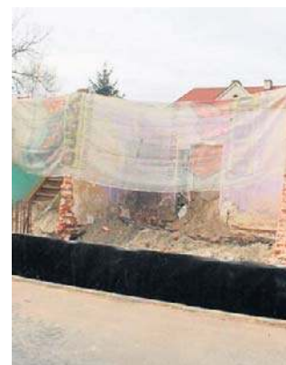
Budynek został niemal w całości rozebrany.
