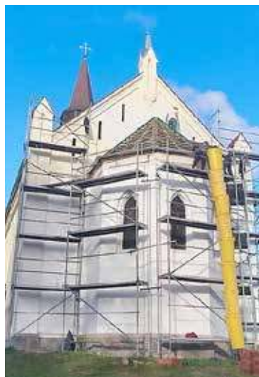
Remontowne były m.in. mury kościoła (fot. Gm. Przybiernów)
