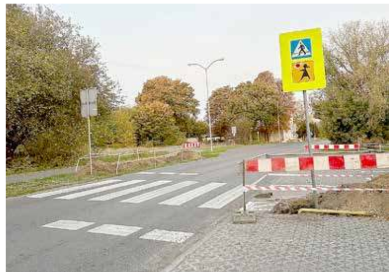
Jednym z doświetlonych przejść dla pieszych będzie to położone przy przedszkolu (fot. Gm. Goleniów)
