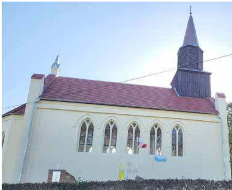
Kościół w Rzystnowie został wyremontowany (fot. Gm. Przybiernów)
