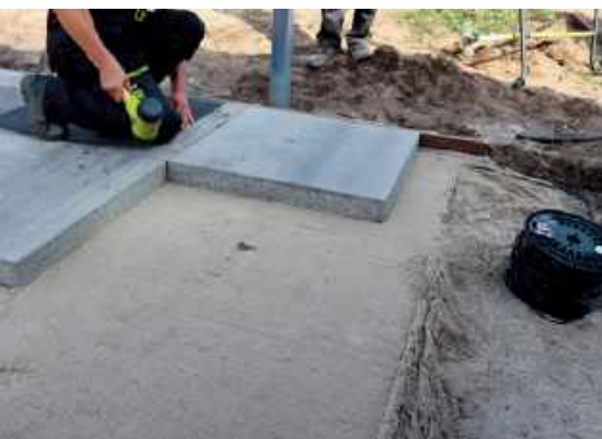
🔧 Płyty tarasowe układane na podbudowie. LIBET
