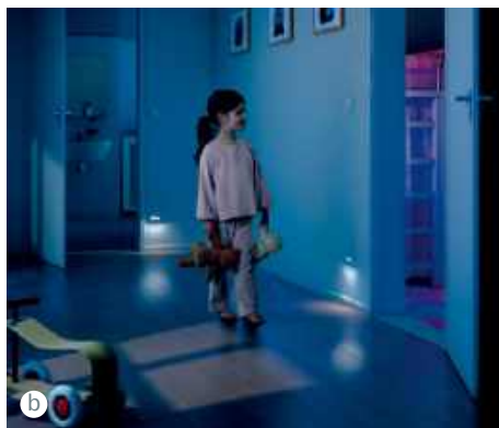
📌 Diody LED zamontowane nad stopniami schodowymi (a ZAMEL) i w korytarzu (b SCHNEIDER ELECTRIC) znacznie ułatwiają komunikację w nocy.
