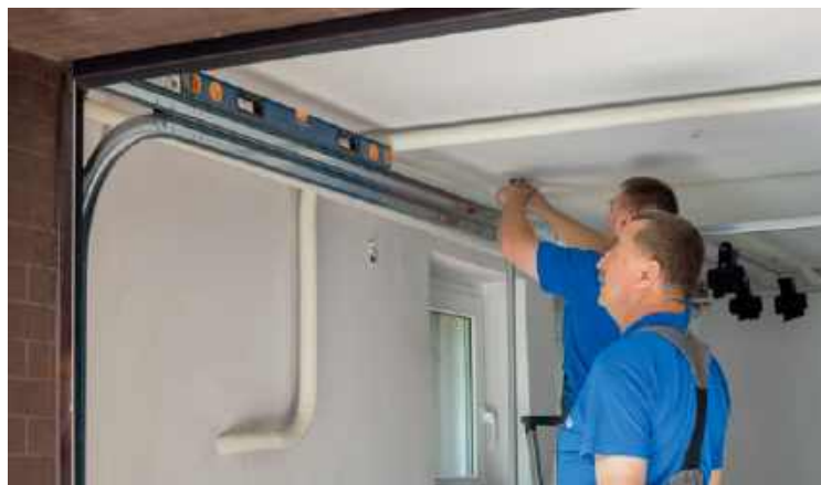
🕒 Bramę garażową montuje się w wykończonym wnętrzu. NOVOFERM
