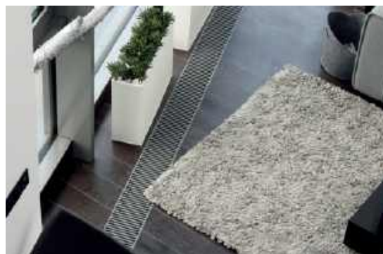
🔔 Modele kanałowe kojarzą się raczej z nowymi domami i dużymi przeszkleniami. Jednak specjalne niskie warianty można ukryć w podłodze również w trakcie remontu. VERANO
