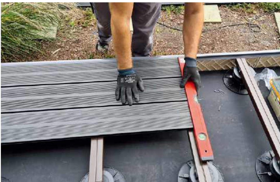
➡ Montaż desek kompozytowych na wspornikach – to tzw. taras wentylowany. RENOPLAST
