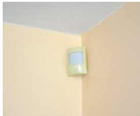
Czujniki ruchu instaluje się na wysokości 2,10–2,40 m od posadzki, tak aby obejmowały swoim zasięgiem okna i drzwi. L. JAMPOLSKA
