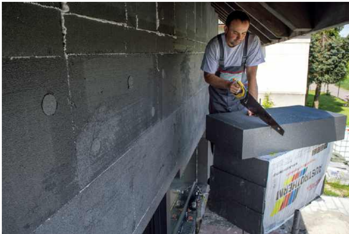
Styropian grafitowy jest nieco droższy od białego, ale ponieważ ma lepsze właściwości termoizolacyjne, można zastosować cieńszą warstwę niż w przypadku białego. AUSTROTHERM
