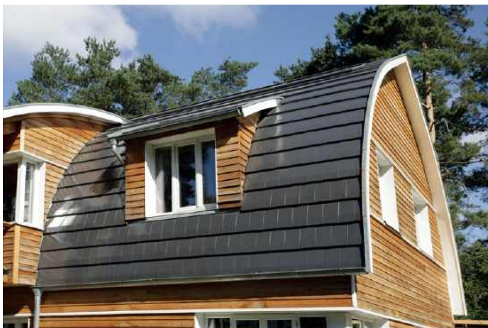
🔗 Niewielkie dachówki łatwo układa się na skomplikowanych więźbach, wokół kominów i okien dachowych. Wykorzystywane są również na ścianach budynków. WIENERBERGER
