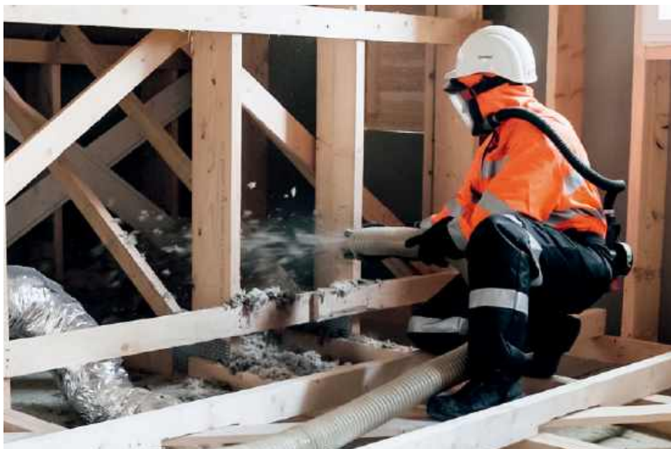
Wdmuchiwanie pod ciśnieniem wełny w granulacie. PAROC
