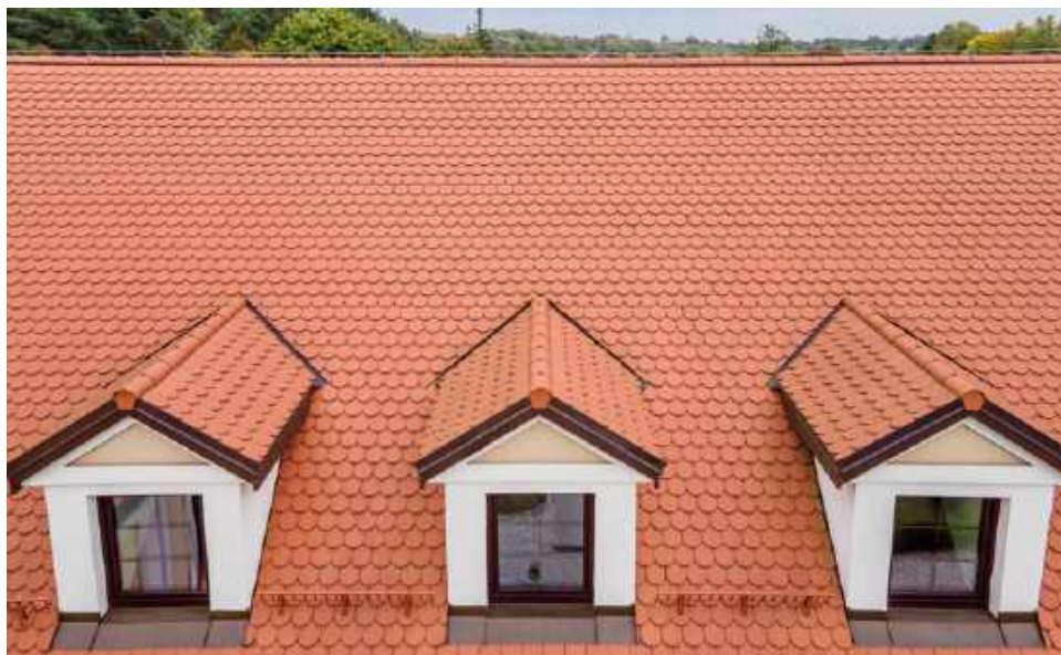
🔗 Tradycyjna ceramiczna karpiówka. Dachówki ceramiczne od stuleci cenione są za wyjątkową trwałość i elegancki wygląd. Choć pokrycie takie jest ciężkie, a wykonanie solidniejszej więźby dachowej oznacza większe koszty, nie zniechęca to licznych inwestorów do stosowania tego materiału. CREATON POLSKA
