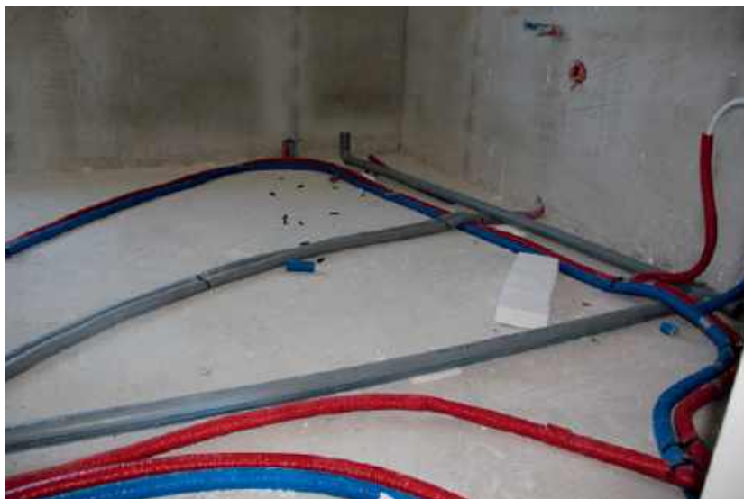
🔧 Rury instalacji wod.-kan. rozprowadzone w łazience, później zostaną ukryte w warstwach podłogi. J. WERNER
