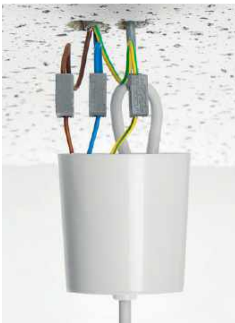
🔧 Do łączenia przewodów elektrycznych w instalacji oraz podłączenia lamp należy stosować tylko specjalne złączki. WAGO-ELWAG
