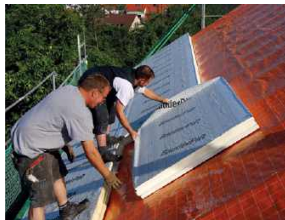
Do ocieplenia nakrokwiowego bardzo nadają się twarde płyty poliuretanowe. BAUDER
