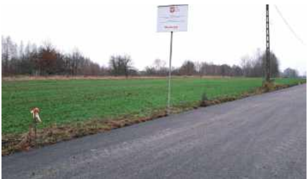
Inwestycja objęła swoim zakresem wykonanie nawierzchni z betonu asfaltowego na powierzchni 1 930,74 m 2 i długości 475 m
