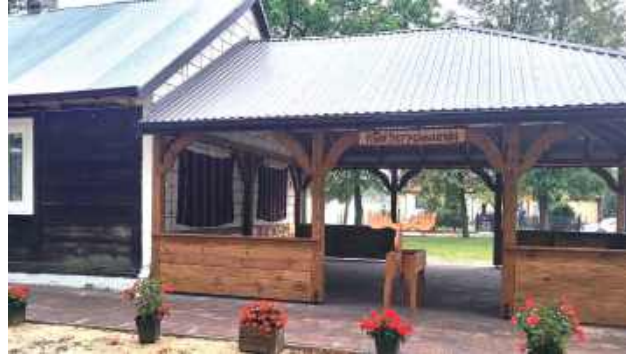
Mieszkańcy sołectwa własnymi siłami zbudowali altanę przy budynku świetlicy
