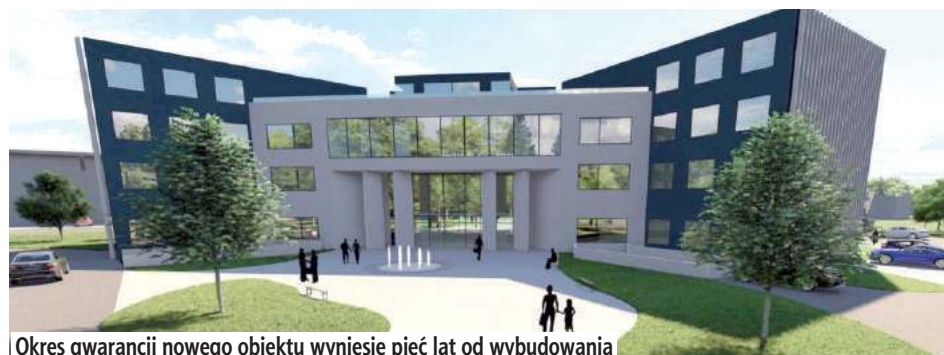
Okres gwarancji nowego obiektu wyniesie pięć lat od wybudowania
