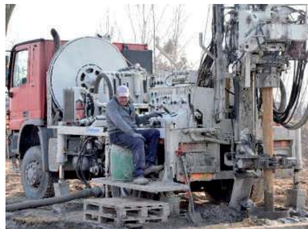
Stację uzdatniania wody w Woli Okrzejskiej buduje firma Wojciecha Słomki SW Team z Woli Kisielskiej w gminie Stoczek Łukowski
