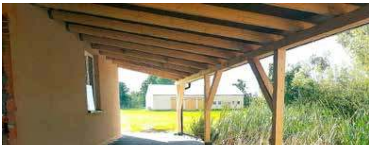
Przy Świetlicy w Zawadach powstał daszek.
