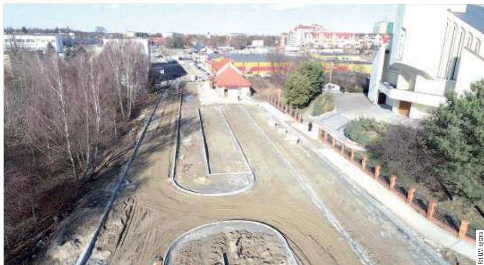
Projekt pn. „Budowa drogi gminnej nr 105399L o długości 268 m, drogi gminnej nr 105400L o długości 366 m oraz drogi gminnej o długości 774 m, w miejscowości Łęczna - Etap I” został dofinansowany ze środków Rządowego Funduszu Inwestycji Lokalnych
