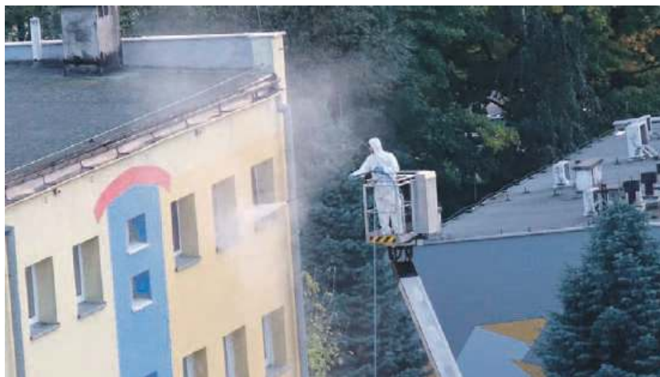
Pracownicy podczas czyszczenia bloku przy ul. Chrobrego 64. Widoczny jest budynek i osoba na wysięgniku.
