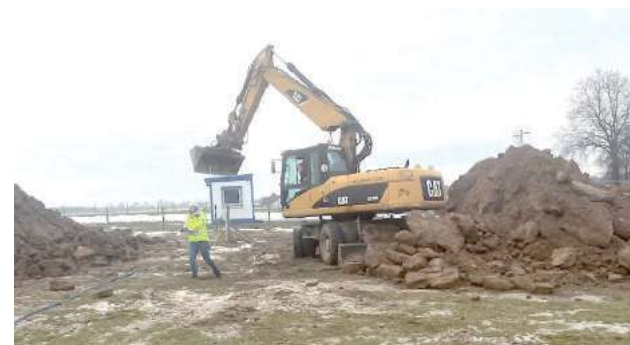
Według umowy budynek w stanie surowym ma być gotowy w lipcu
