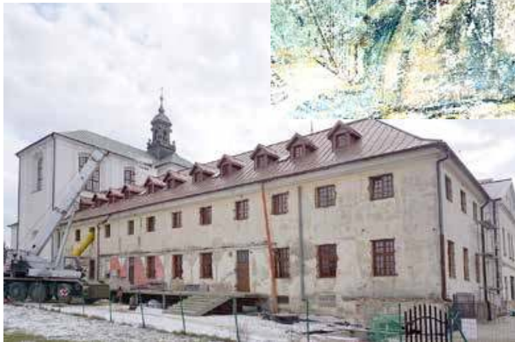
W węgrowskim klasztorze trwają prace. U góry jedno z odkrytych malowideł.
