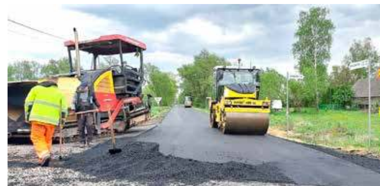
Jedna z przebudowywanych dróg
