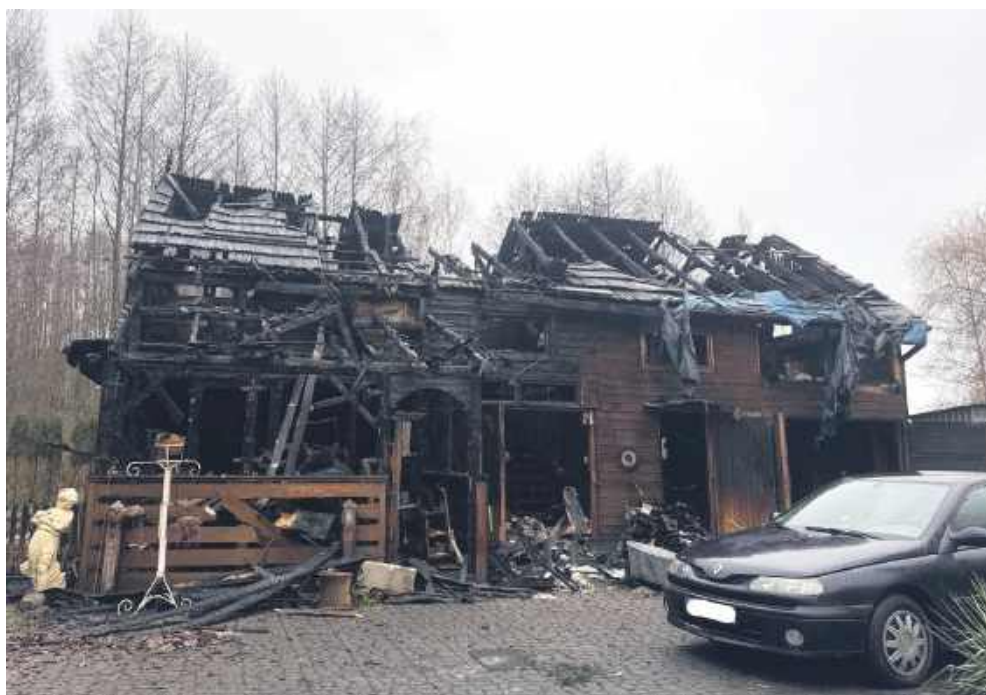
Tyle zostało ze spalonego domu
