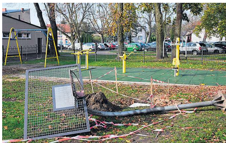
W piątek w południe widać było, że do zamontowania pozostał jeszcze zestaw do gry w kosza.
