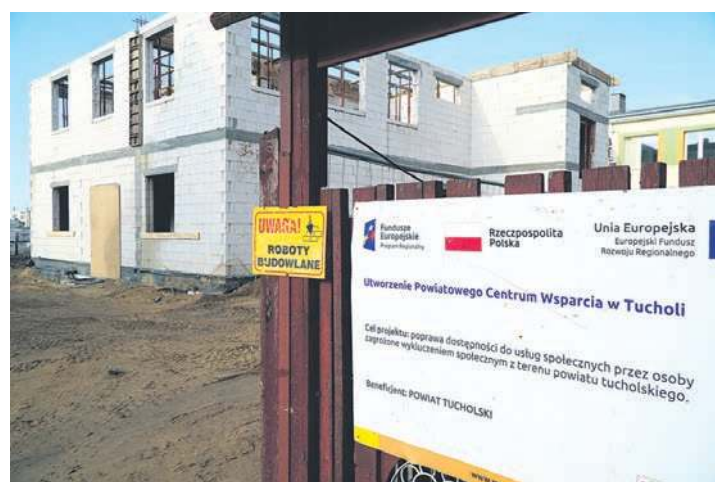
Plac budowy przy ul. Kościuszki w Tucholi.
