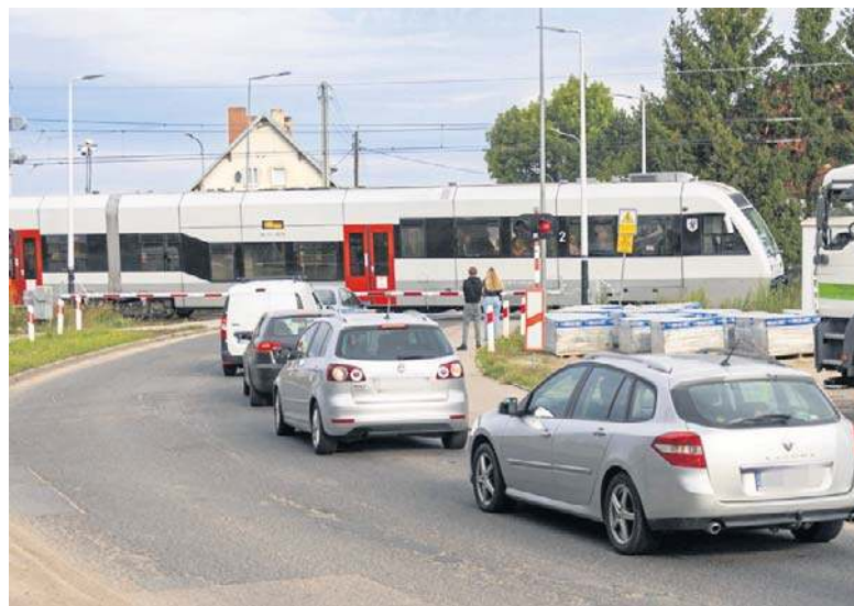
Przejazd kolejowy w Kobylnicy. Niedawno przeszedł modernizację
