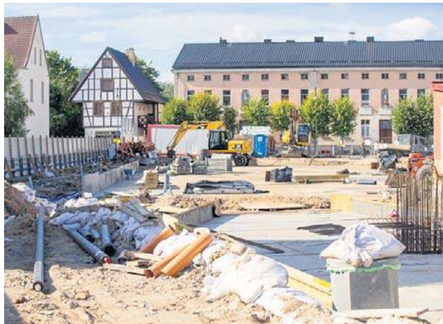
Budowa Bytowskiego Centrum Kultury
