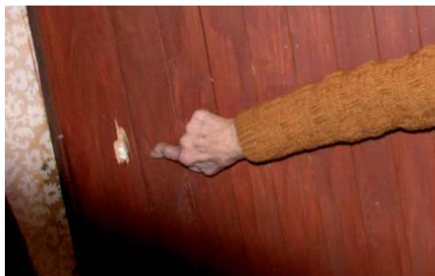
Otwór wylotowy po wewnętrznej stronie drzwi
