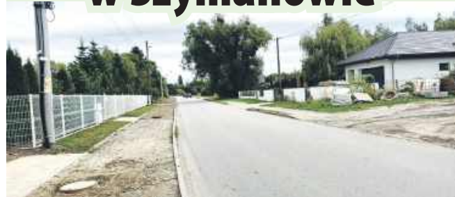
Modernizacja drogi powiatowej nr 1370D
