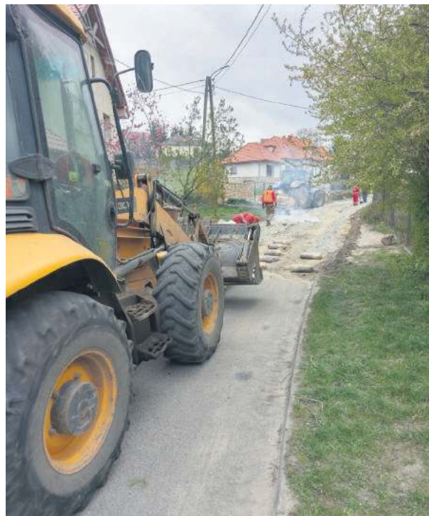
Firma z Brzegu rozpoczęła remont ulicy Dębowej w Gęsińcu
