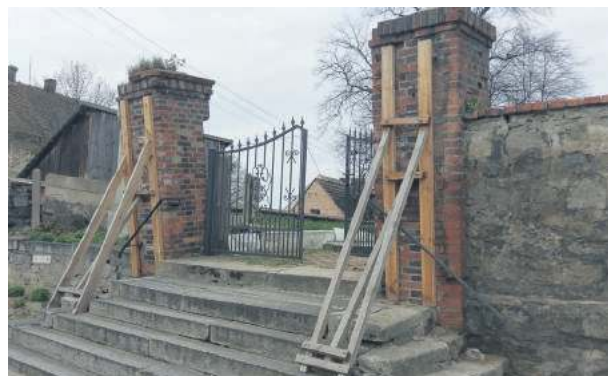
Drewniane rusztowanie podpira słupy już kilka miesięcy
