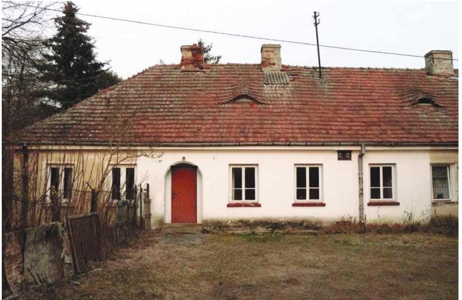
Zabytkowa oficyna przy ruinach pałacu
