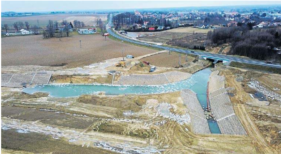
Zbiornik powstaje w naturalnym zagłębieniu terenu poniżej DW nr 94 Rzeszów - Dębica i ma chronić Sędziszów Małopolski przed skutkami nawałnych deszczy
