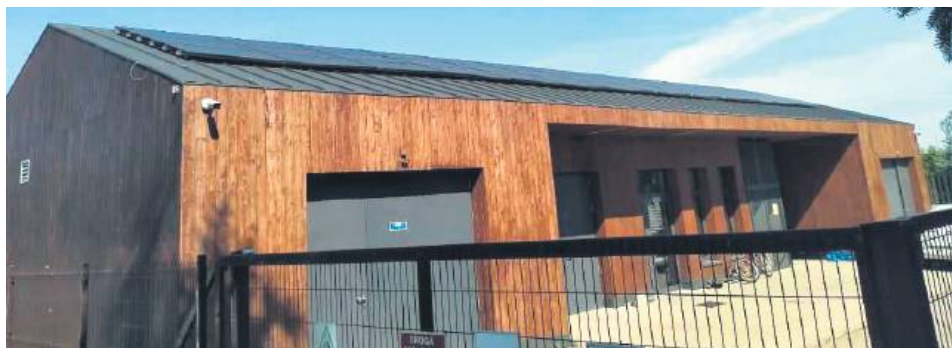
Na trzech pawilonach zamontowane zostały instalacje fotowoltaiczne, wytwarzające prąd z energii słonecznej.
