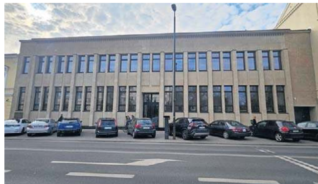
Dwukondygnacyjny budynek biurowo-usługowy został wzniesiony w 1934 r.
