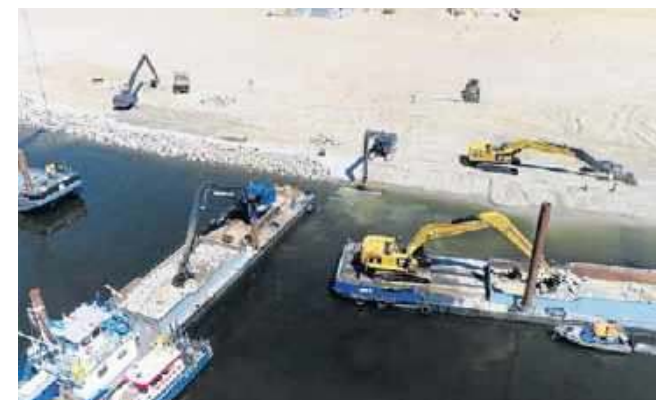
Wykonawcą prac jest konsorcjum firm Dredging International i Van Oord Dredging and Marine Contractors
