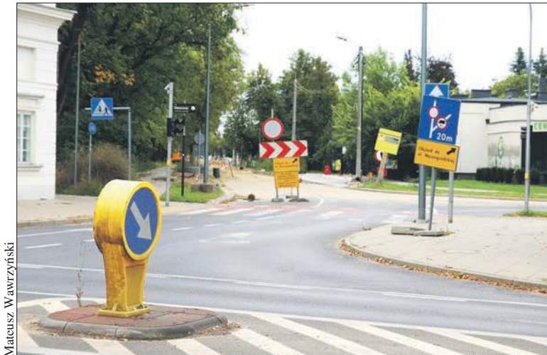
Według planu prace remontowe na odcinku ul. Wyszogrodzkiej od skrzyżowania z ul. Słoneczną obok Rogatek Warszawskich po ul. Spółdzielczą powinny zakończyć się w tym roku
