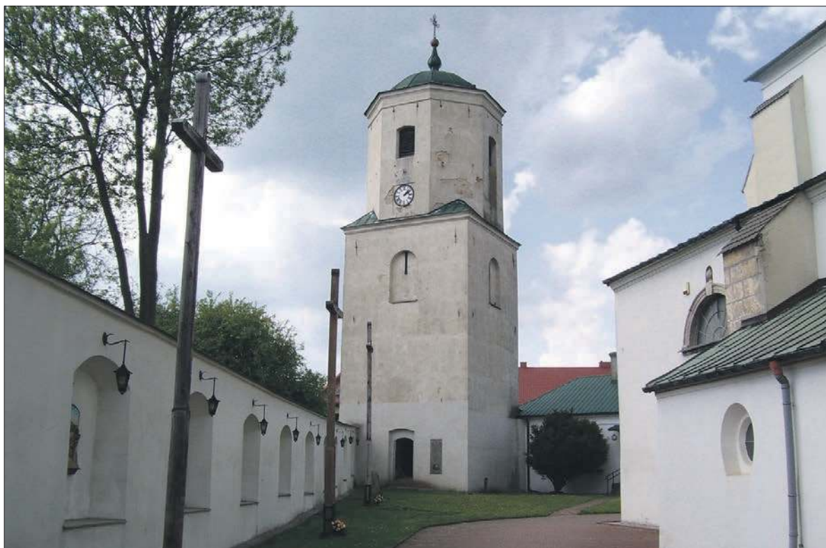
Stara wieża obronna przerobiona na dzwonnice przy kościele farnym w Ilży
