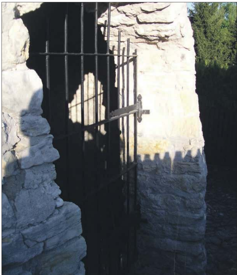
Wejście do pieców ceramicznych zabezpieczone kratą
